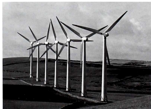
Рисунок 2.48. Ветряные электростанции с вертикальной осью вращения
